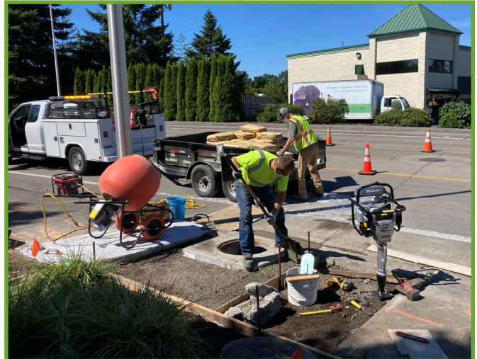
Prepping for pouring
