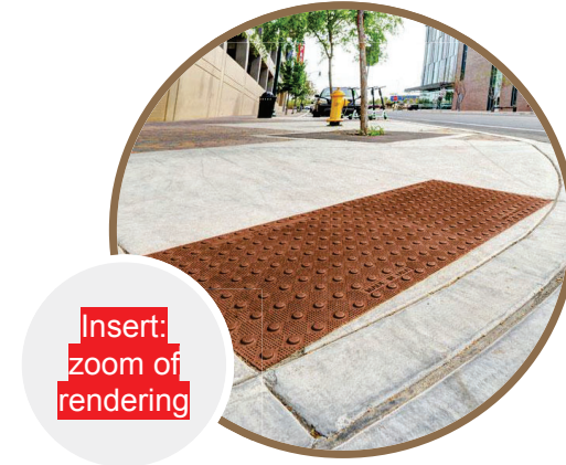
ADA TACTILE PAD
