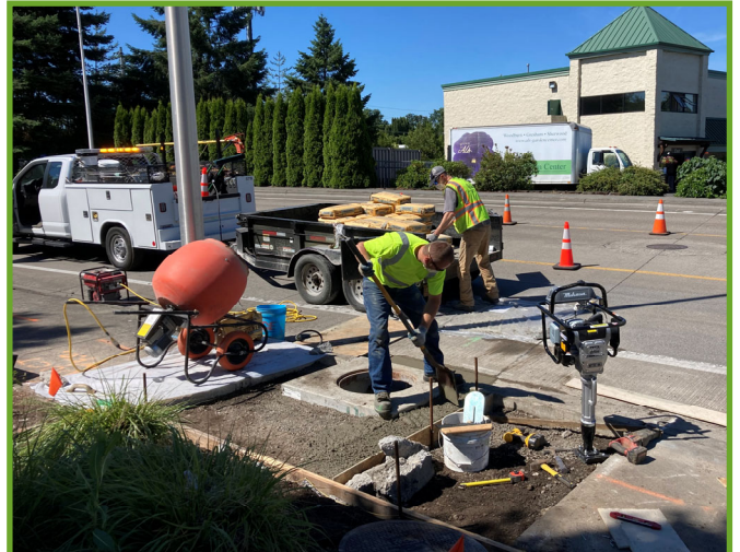
Prepping for pouring
