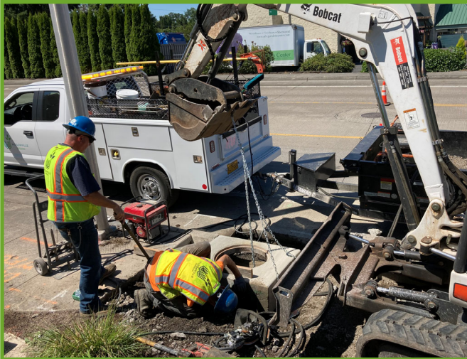
Placing the lid
